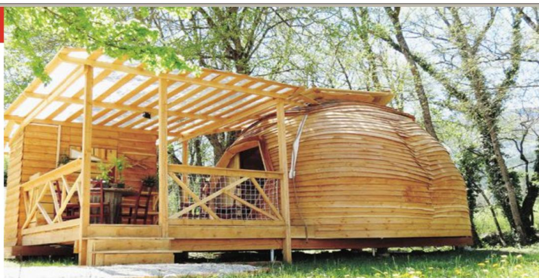
Loïc Cherigie a construit ce dôme de 25 m 2 dans le camping municipal des Ecoreuils à Recoubou-Jansac (Drôme). L'ADIE
